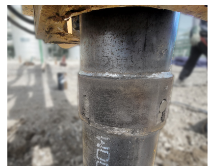
원터치 케이싱 커플러 조립 모습 (조립 이후 해체 불가)
