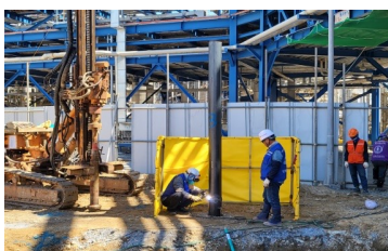
용접작업 시 불티방지막, 화기감시자 배치
