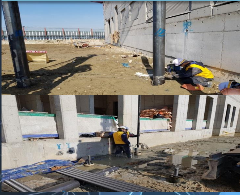
힐스테이트 송도 2차 신축 공사
