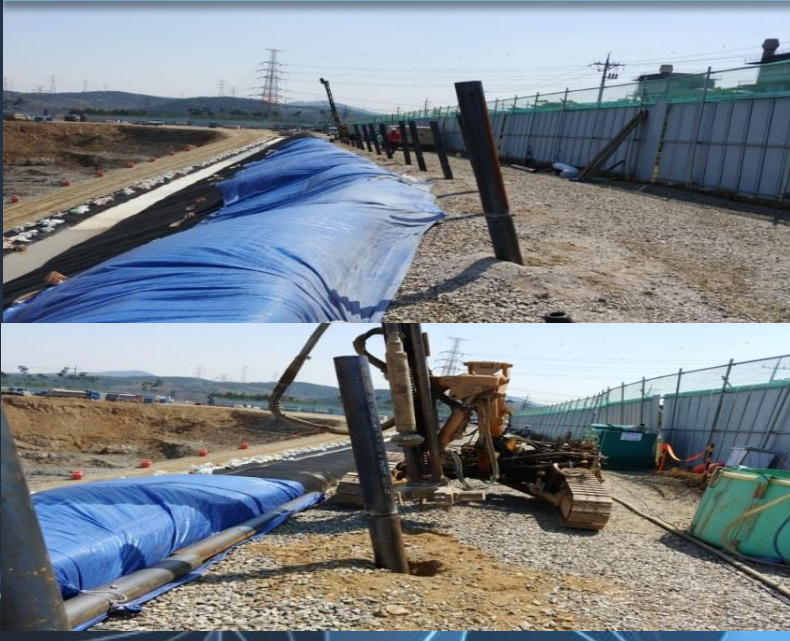
서산 오토밸리 폐기물처리시설 신축공사
