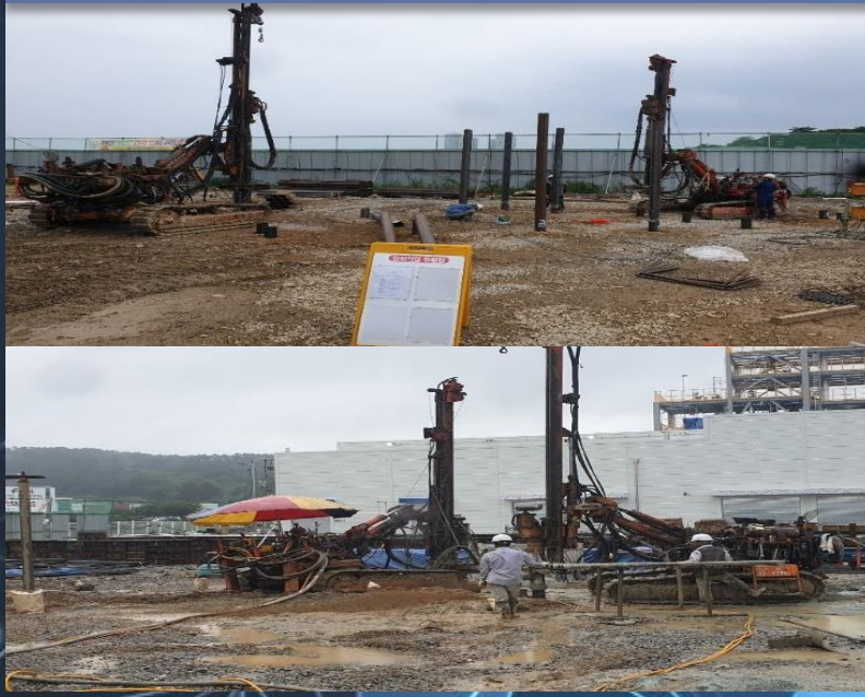
원익 머트리얼즈 오창 증축공사
