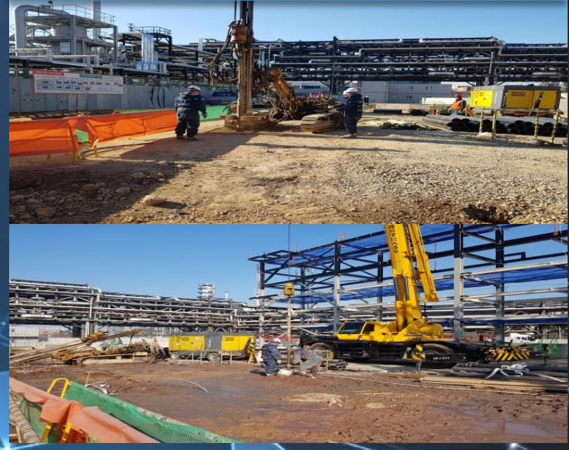
SK에너지 울산 공장 S-PROJECT 중 PUMP FOUNDATION
