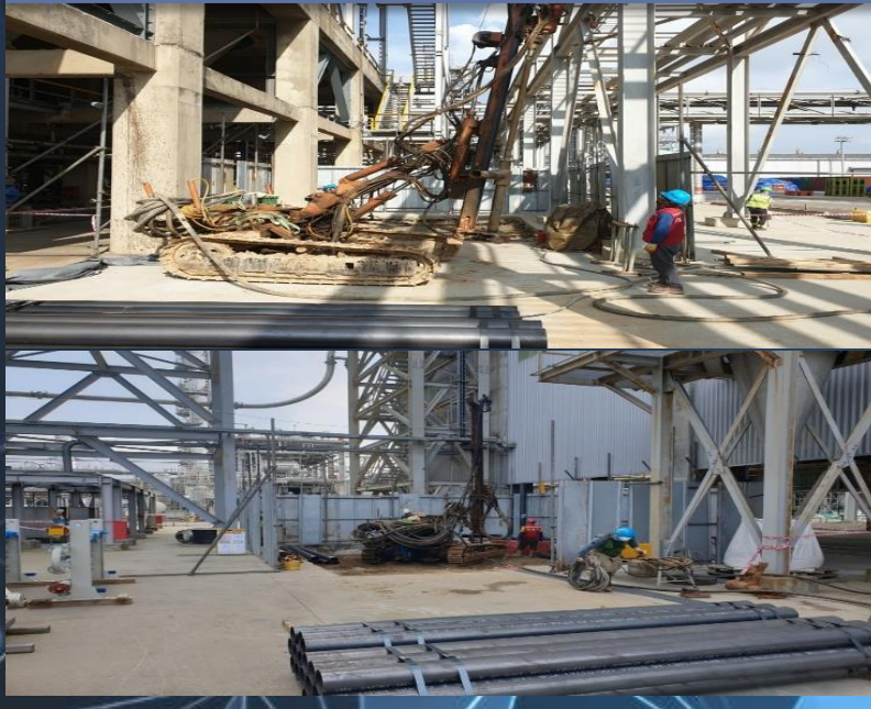
LG화학 OXO SRU NH3 SCRUBBER 토목공사
