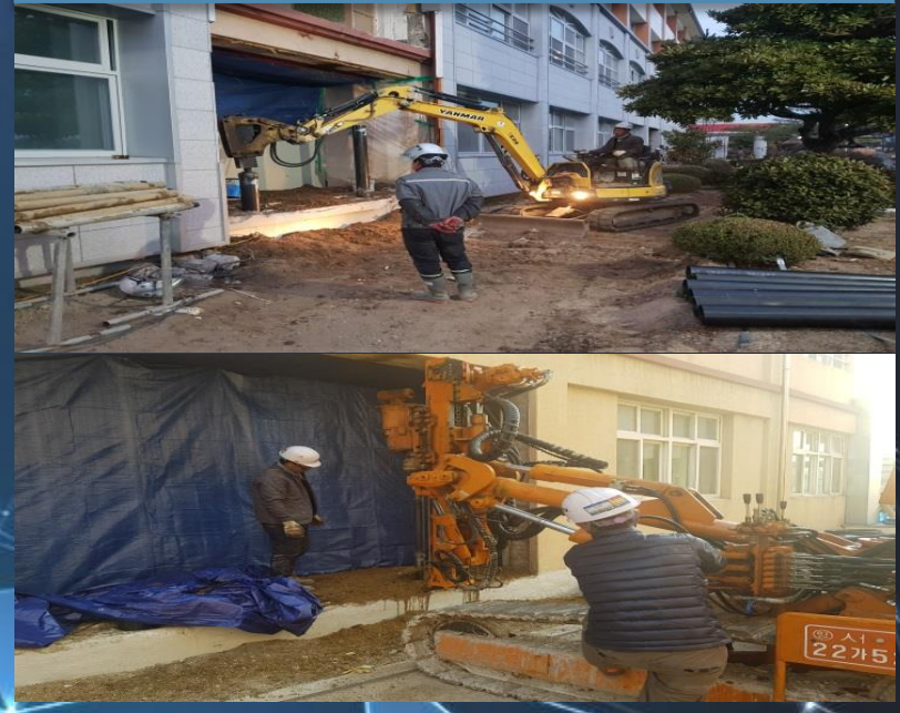
경주 선덕여자고등학교 내진보강공사
