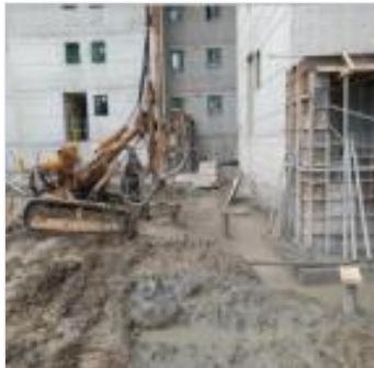
A PILE 공사
